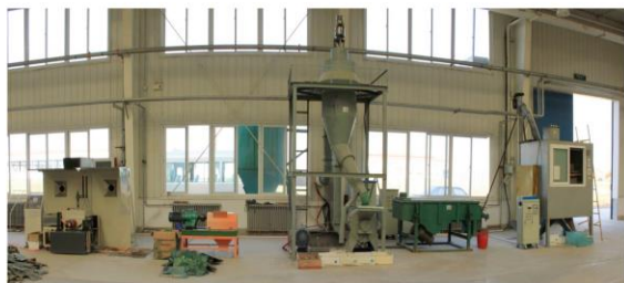
团队自主研发的电路板回收示范线
