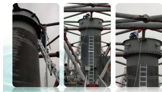
2019年6月，在淮芜线 1000kV（特高压）电力铁塔(277米)上进行了试点应用!
